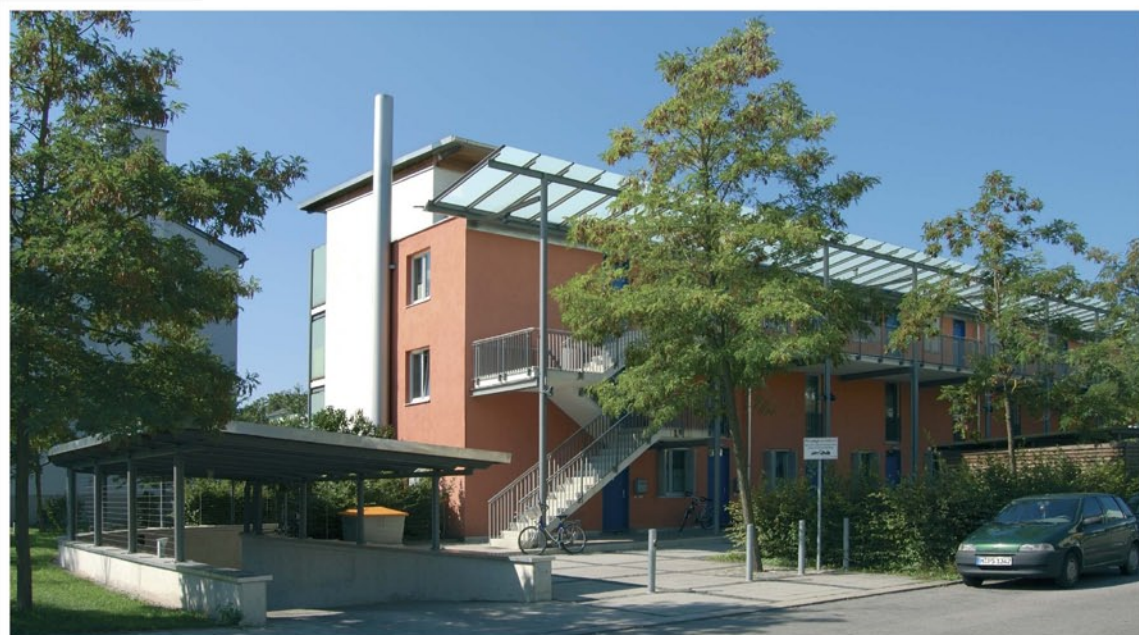
Blick vom Nordosten
