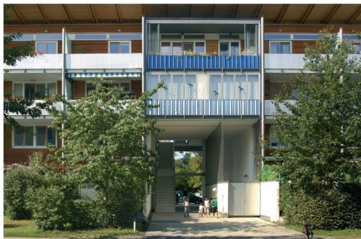
Fassade Innenhof mit Durchgang zur Straße
