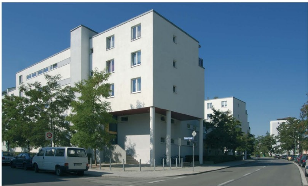
Kopfbau an der Aschenbrennerstraße
